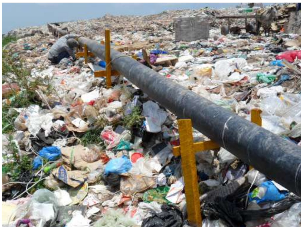
Figura 31 – Funcionário fazendo a manutenção do tubo. Fonte: Arquivo CRA.2011
