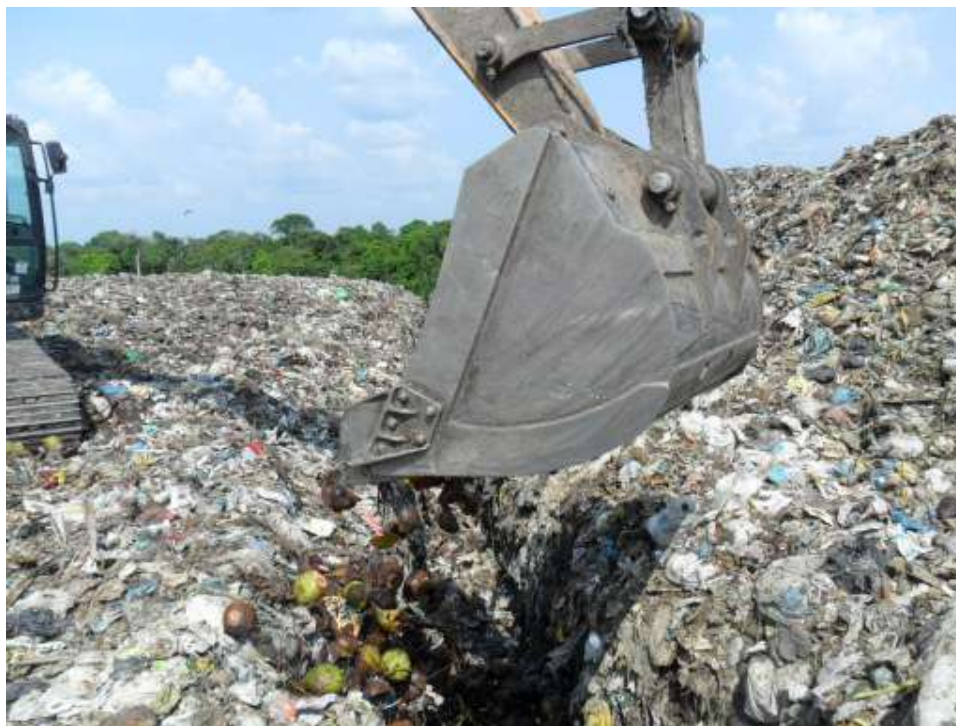
Figura 25 – Cobrimento da vala com cocos. Fonte: Arquivo CRA, 2011.
