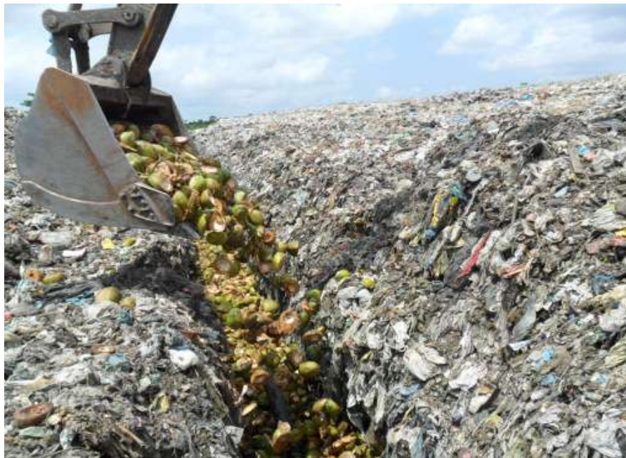
Figura 32 – Cobrimento da Vala no Aterro Aurá. Fonte: Arquivo CRA. 2011
