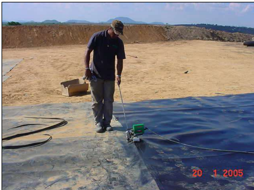
Figura 34 – A forma ideal de não contaminar o solo seria utilizar mantas de PEAD (polietileno) para não permitir que o chorume atinja o solo e o lençol freático. Fonte: Arquivo CRA. 2011
