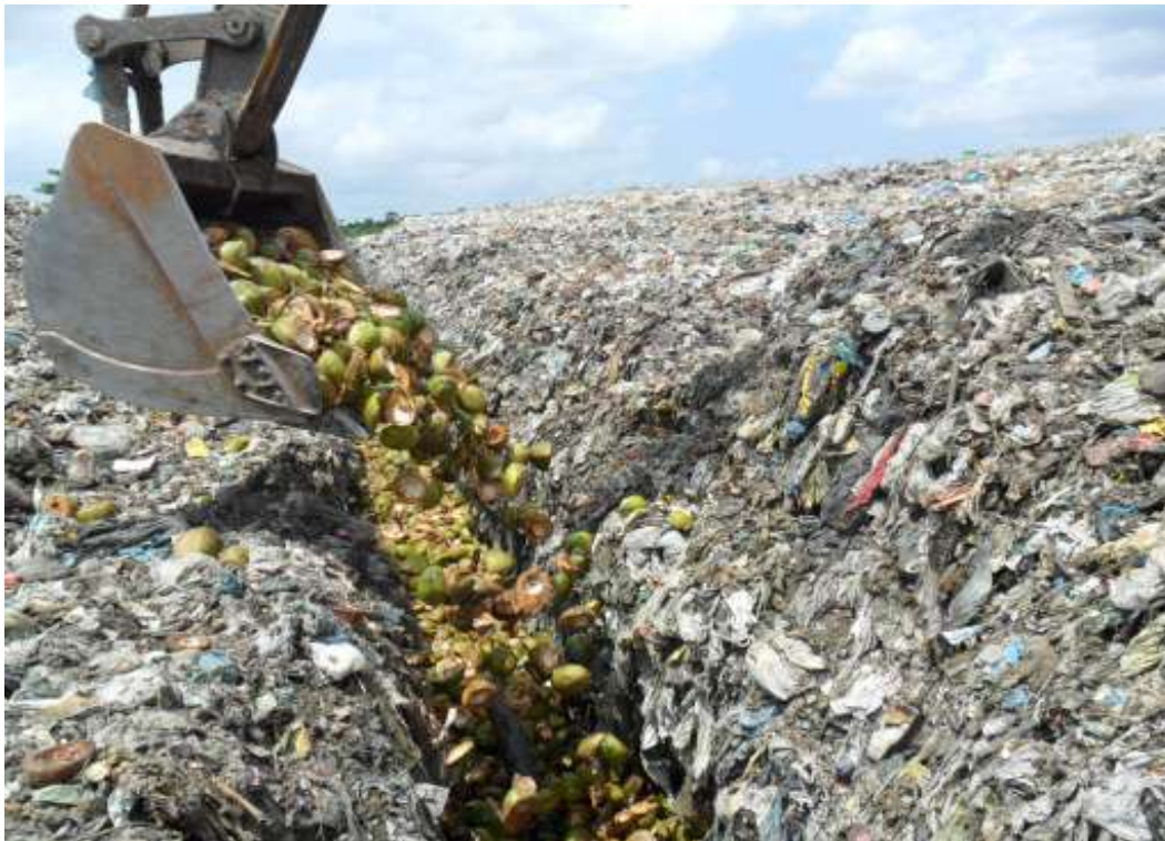
Figura 26 – Cobrimento da Vala no Aterro Aurá. Fonte: Arquivo CRA, 2011.
