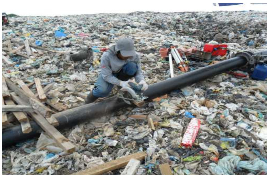
Figura 28 – Trabalhador faz reparos no coletor. Fonte: Arquivo CRA, 2011
