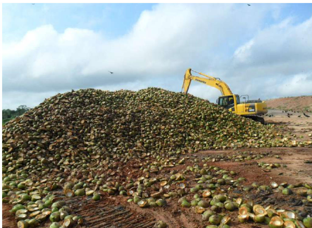
Figura 27 – Cobrimento da vala com cocos. Fonte: Arquivo CRA, 2011.
